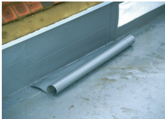
3. att. Malu apdare ar RENOLIT ALKORPLAN 81170 vai 81171 metāla loksni
